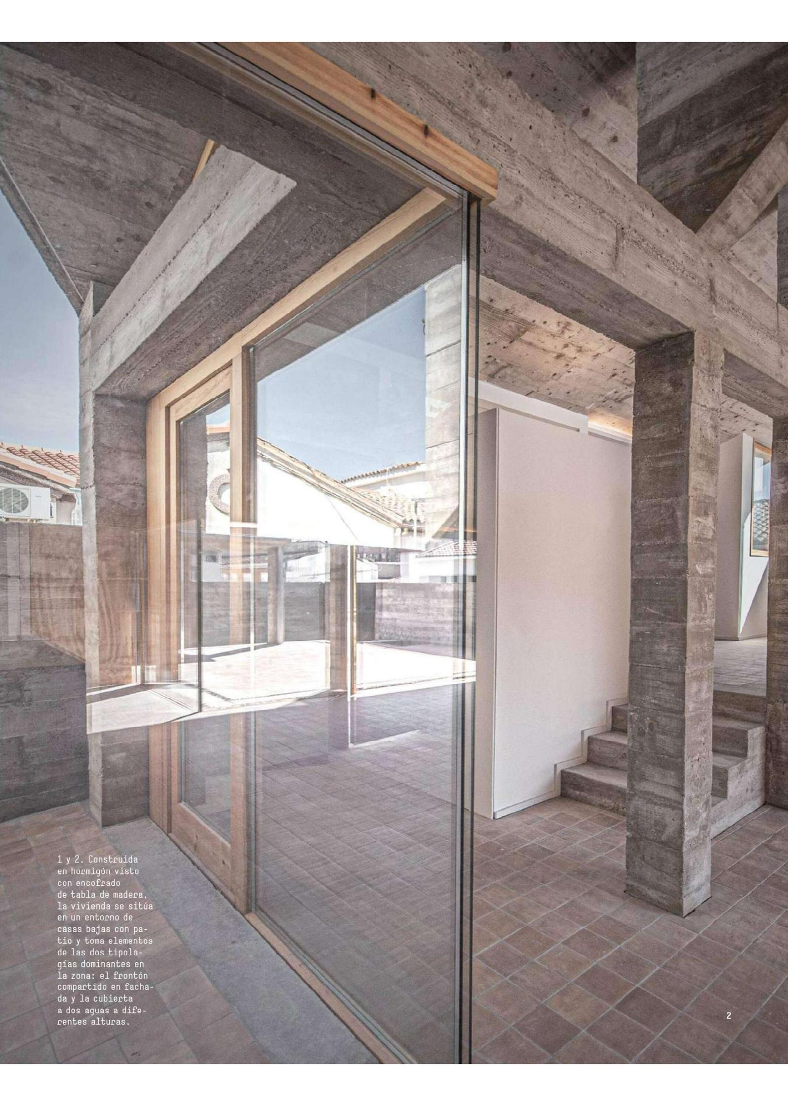
1 y 2. Construida en hormigón visto con encofrado de tabla de madera, la vivienda se sitúa en un entorno de casas bajas con patio y toma elementos de las dos tipologías dominantes en la zona: el frontón compartido en fachada y la cubierta a dos aguas a diferentes alturas.
