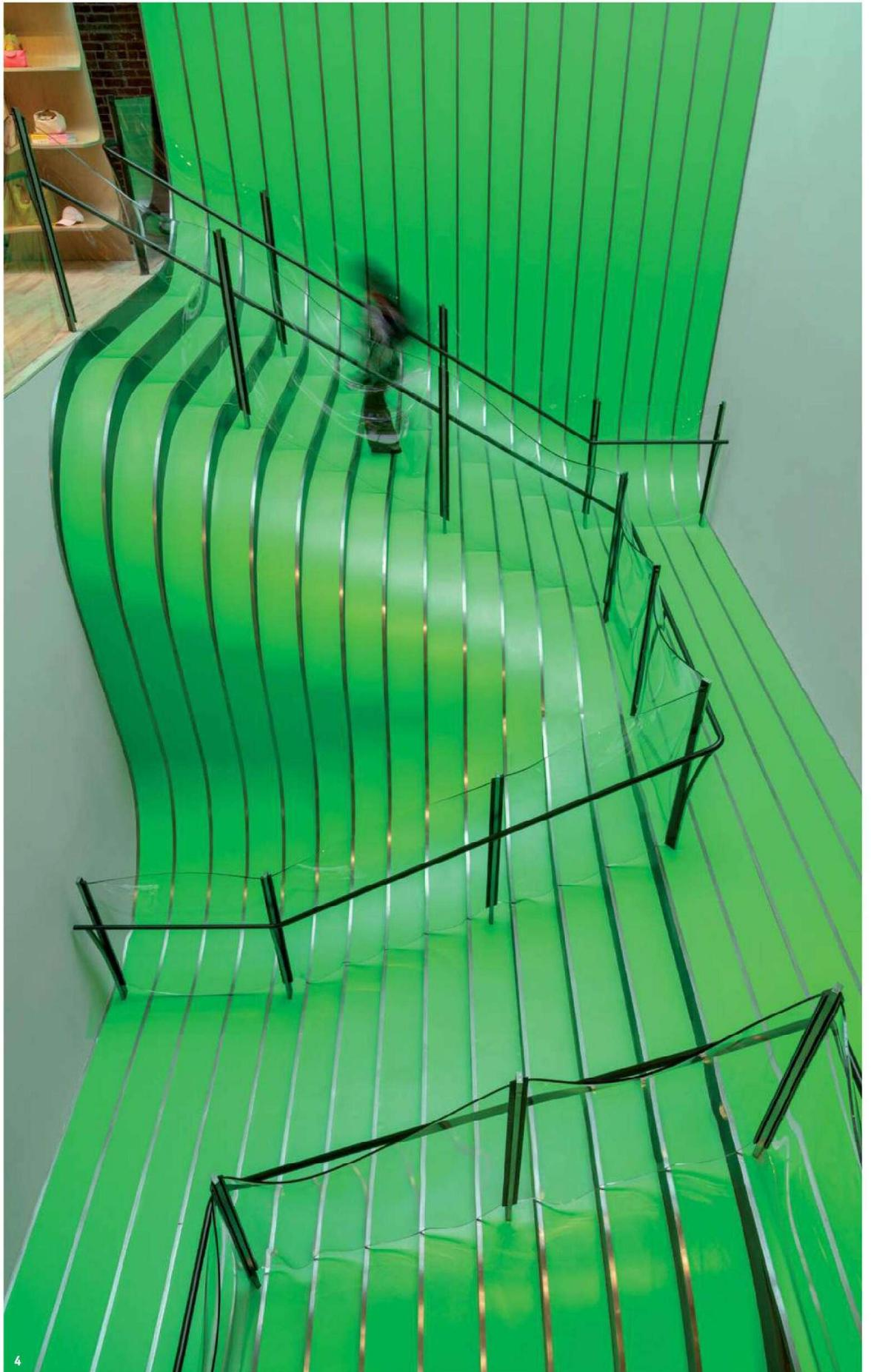
2 y 4. Presidiendo el espacio, la escalera del proyecto original se tiñe con el icónico verde *Energy Green* de Longchamp, que potencia la metáfora de la colina. Fabricada a partir de 30 listones de acero laminado en caliente, conserva las balaustradas de vidrio, que se calientan y doblan para crear un característico efecto ondulado.
