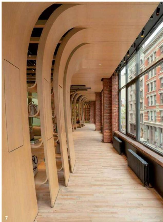
7. Los paneles de madera del falso techo se desenrollan y descienden hacia el suelo, convertidos en expositores y espacio de almacenamiento.
